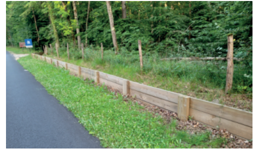
Barrière de protection le long d'une route
